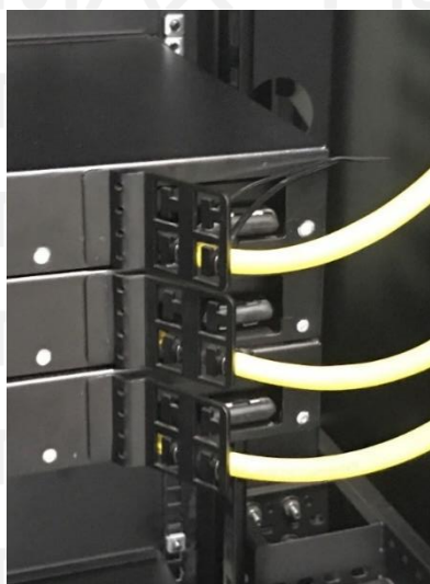
Elemento de fijación posterior lado izquierdo de cables de acometida
