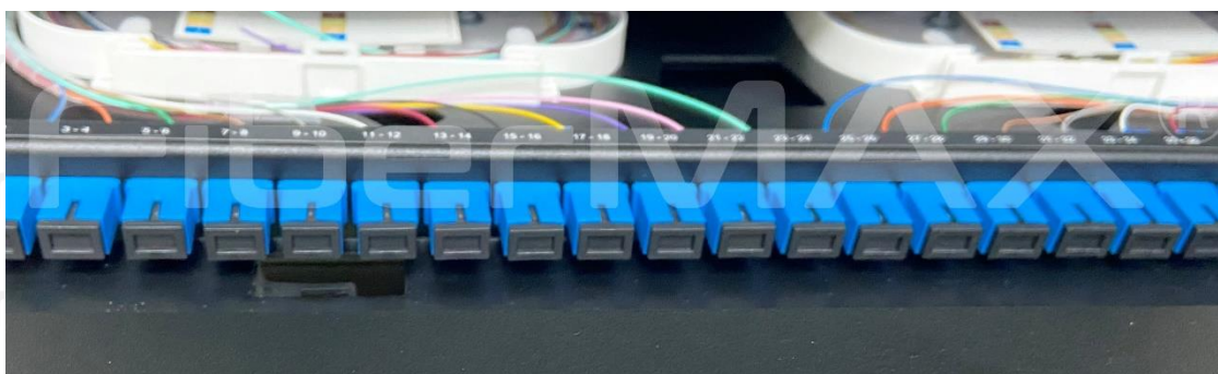
Acoplador SC/UPC, Pigtails con fibra de colores y bandeja porta-fusiones
